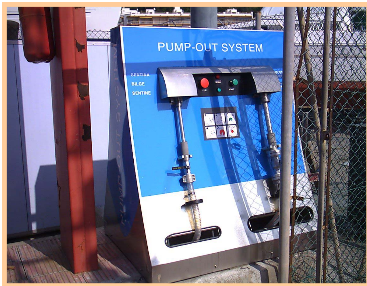
Equip amb les mànegues d'aspiració per sentines i aigües residuals dels WC de les embarcacions
